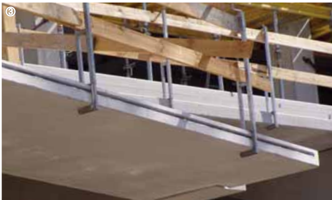
①-④: Befestigung von Geländern, Multifunktionshalle, Berlin
