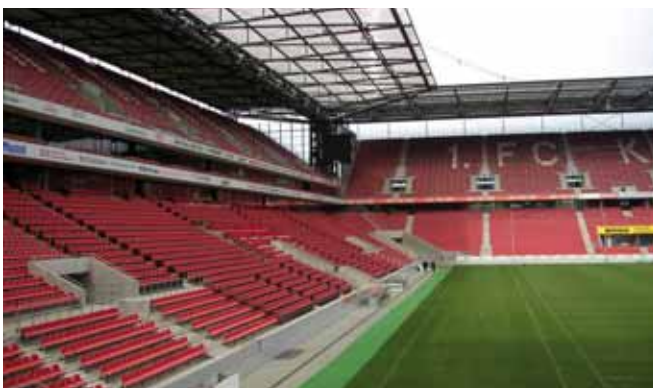
Befestigung Geländer, Rheinenergiestadion/Köln
