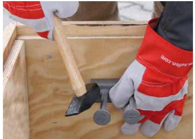
Halfenschienen an die Schalung annageln
